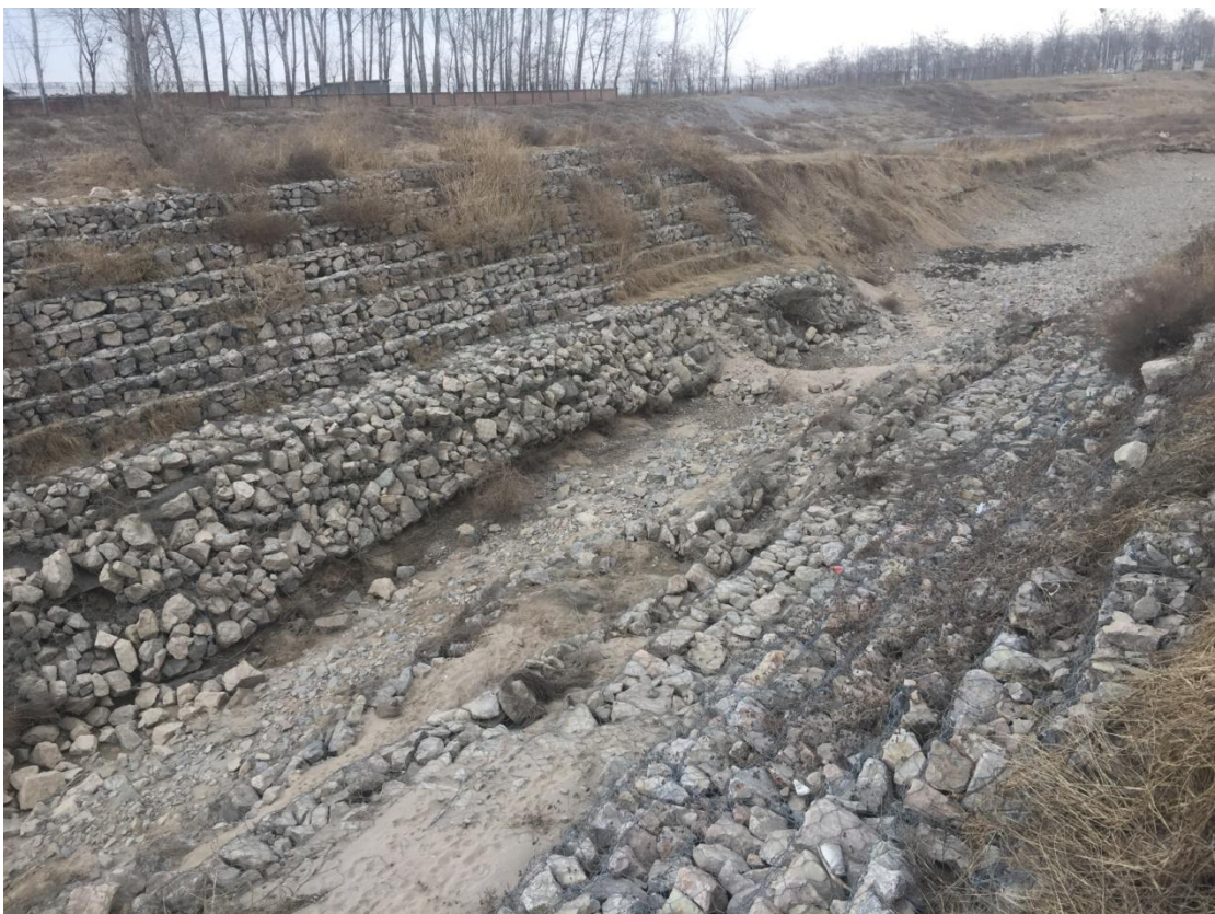
图 1-4 左、右岸坡和下游河底现状
