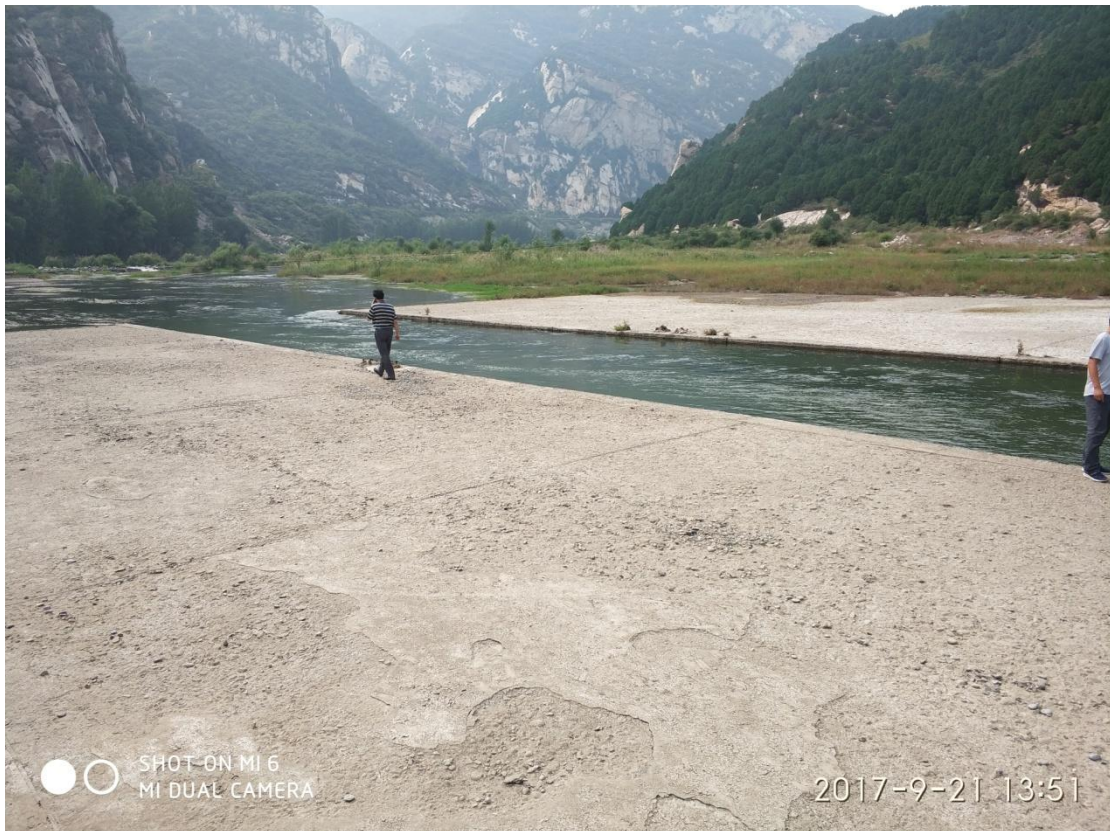
张家坟水文站测流堰
