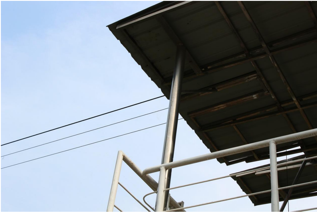
张家坟水文站缆道
