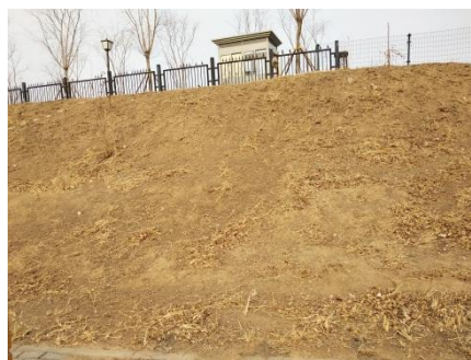
图 3-8 裸露边坡冬季现状
