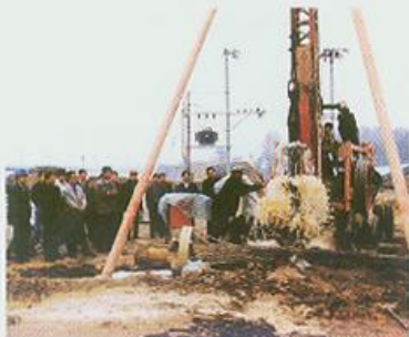
怀柔应急备用水源工程
