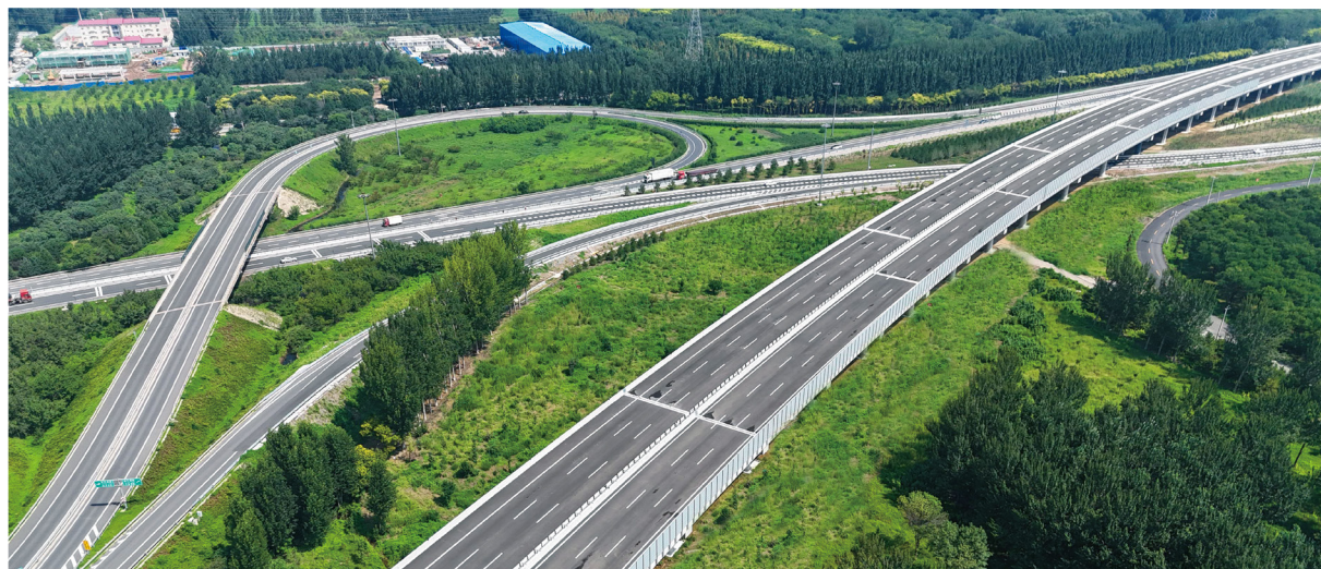
承平高速北京段工程(水土保持措施实施后)
