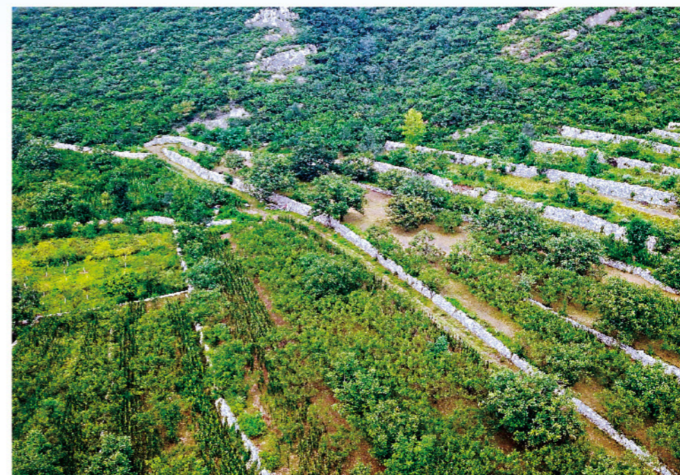
昌平区老峪沟小流域梯田整修
