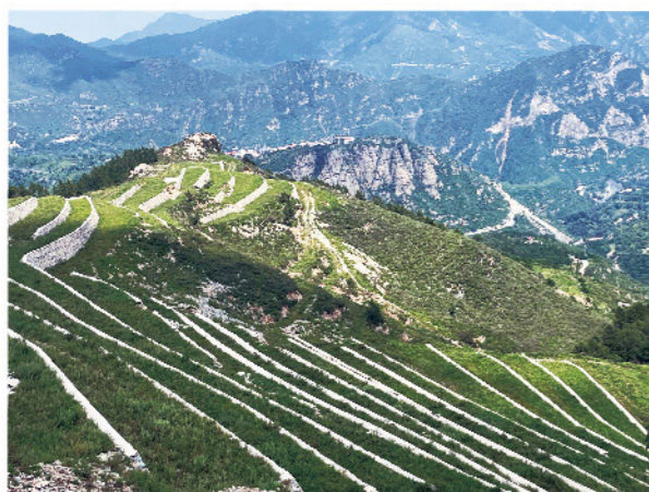
房山区西苑小流域梯田整修
