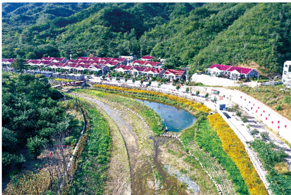
密云区古石峪小流域沟道治理
