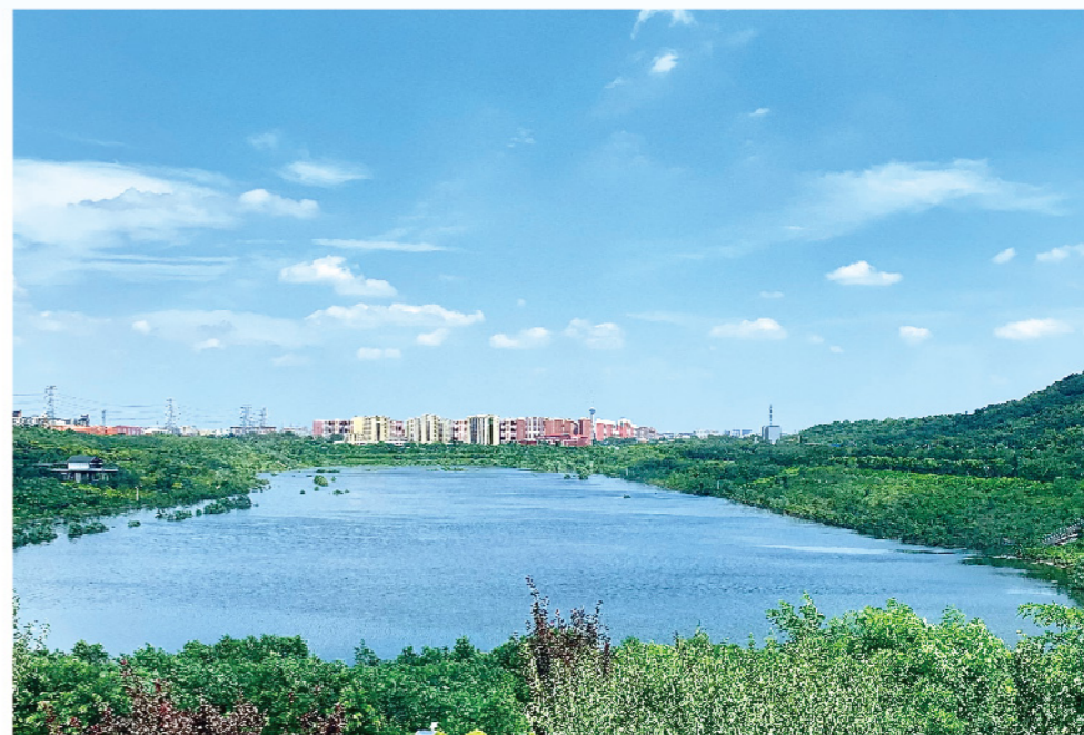
北京市西郊雨洪调蓄工程
