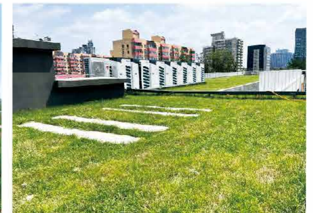
凤凰苑小区配套学校项目屋顶绿化
