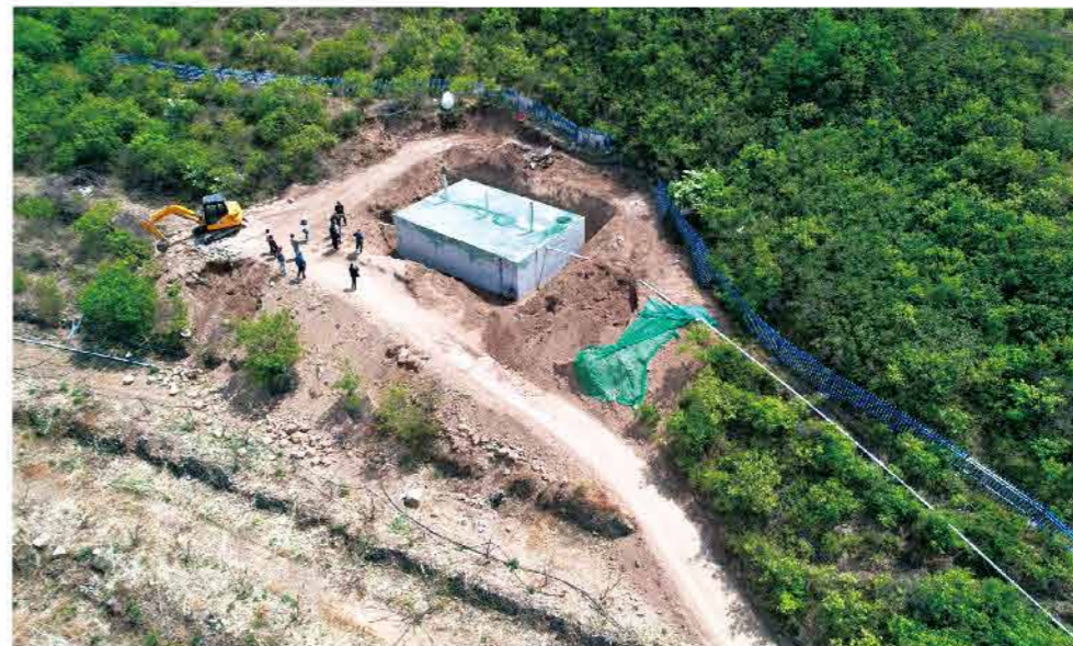
门头沟区国家水土保持重点建设工程现场检查
