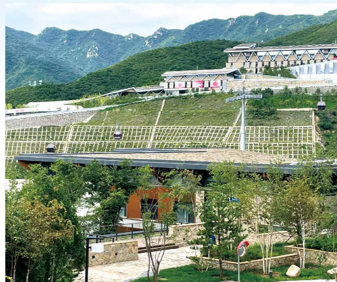
延庆冬奥村项目护坡工程
