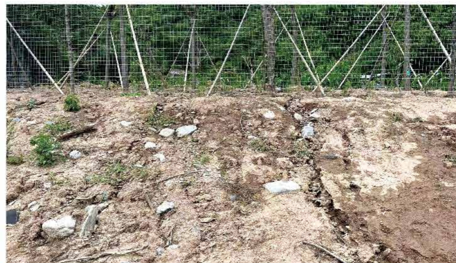
门头沟区门头沟小流域坡面细沟侵蚀
