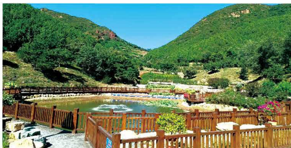
平谷区小峪子小流域蓄水池
