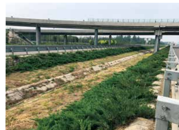
首都地区环线高速公路(通州—大兴段)工程绿化及排水沟
