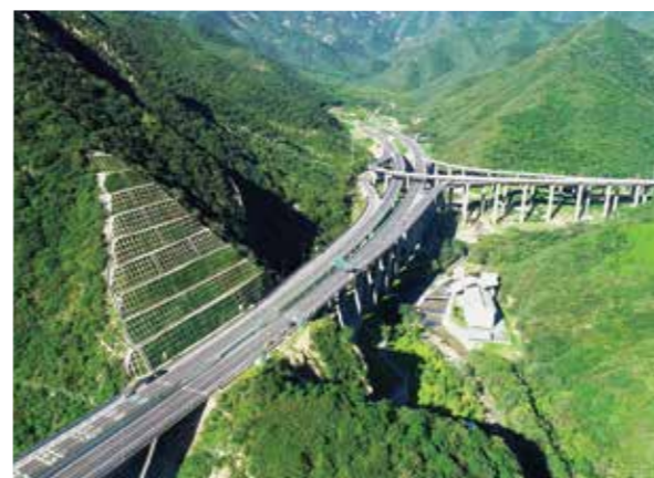
延崇高速九级护坡
