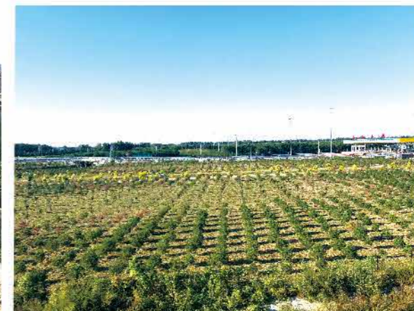
北京大兴国际机场北线高速公路植被恢复
