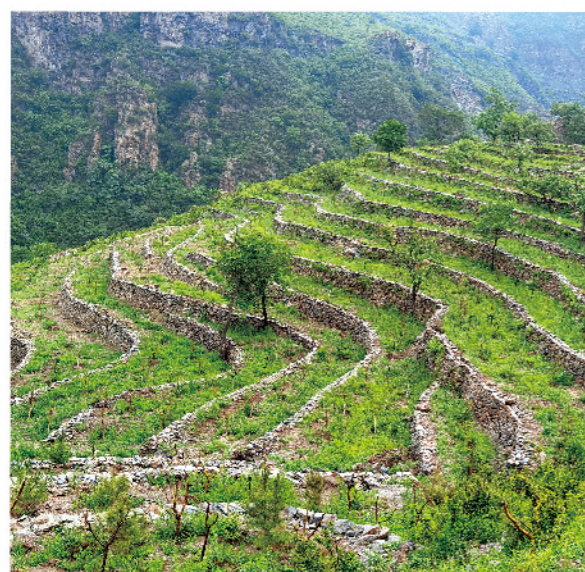
房山区金鸡台小流域梯田整修
