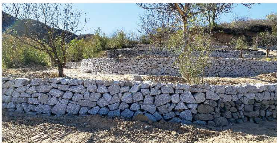
门头沟区东胡林小流域梯田整修
