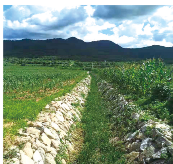
延庆区山西沟小流域田间排水渠
