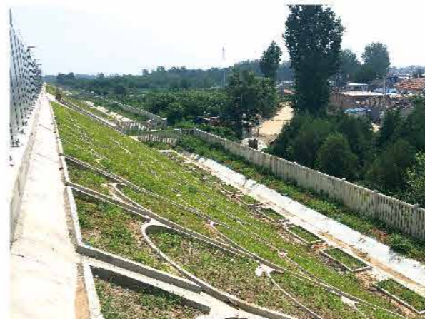
北京至沈阳铁路客运专线边坡防护措施
