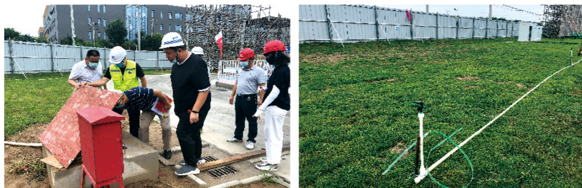
现场检查大兴中关村高端医疗器械产业园项目
