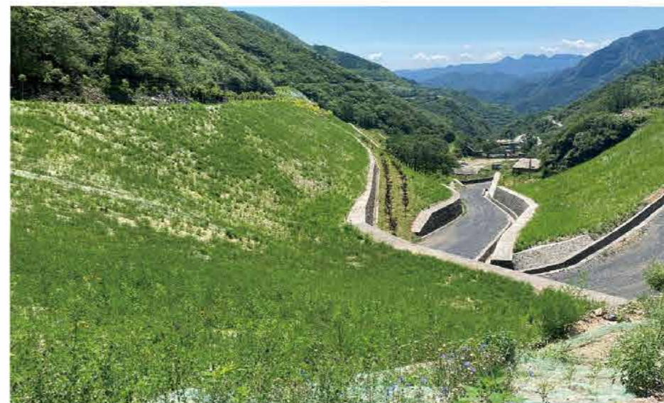
房山区史家营乡大村矿山修复前后
