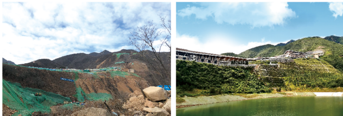
国家雪车雪橇中心边坡防护措施实施前后对比
