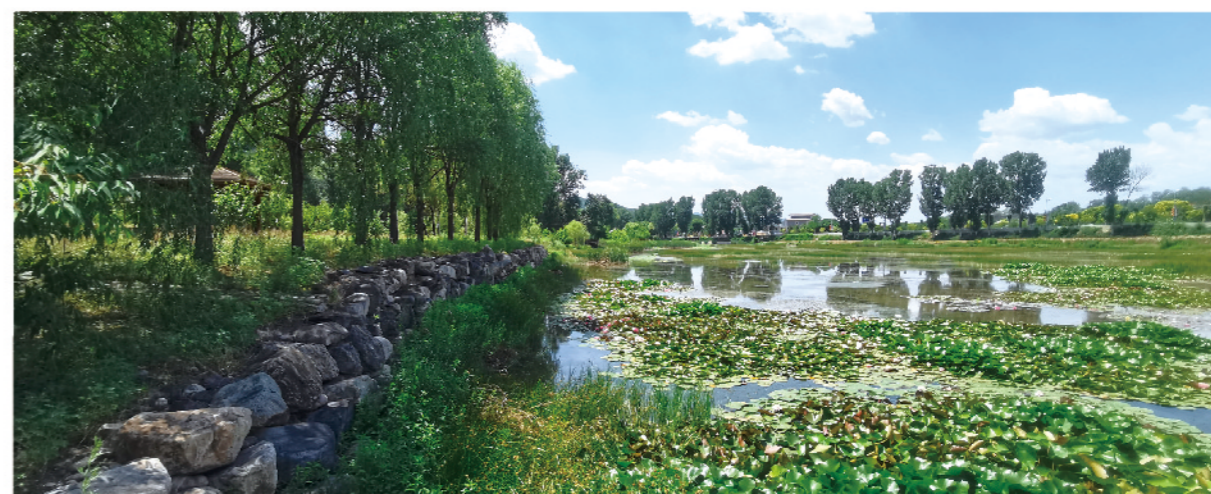
怀柔区老西沟小流域沟道治理
