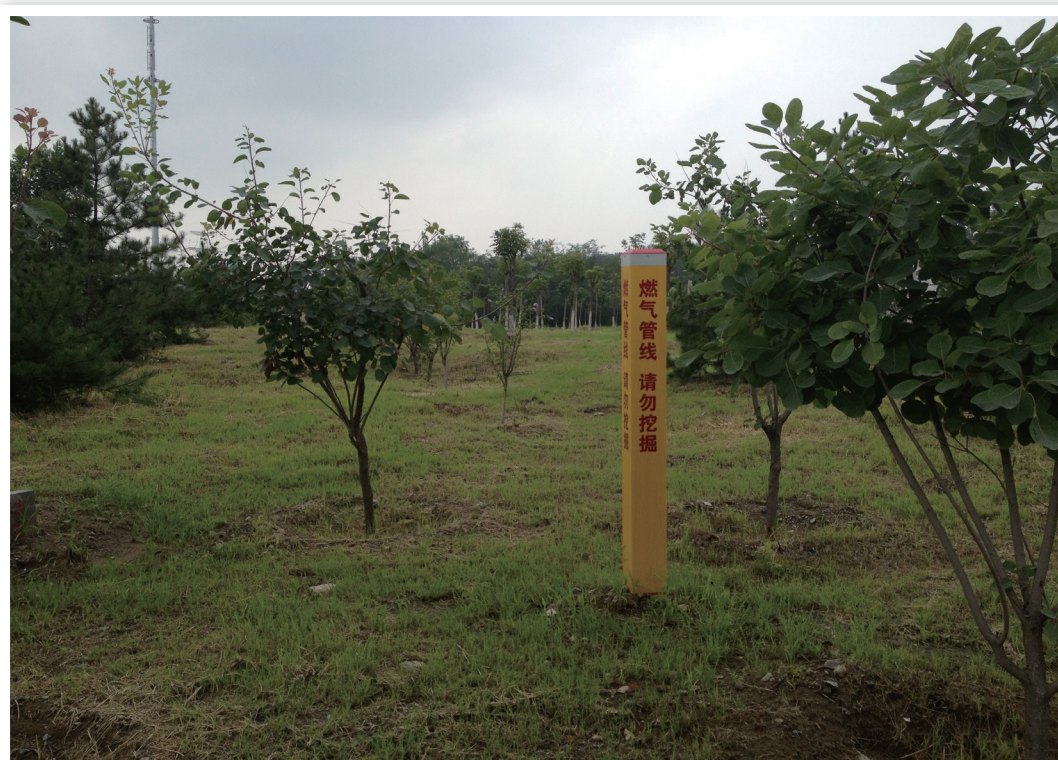
西北热电中心天然气供气工程水土保持措施
