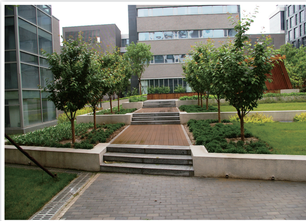
北工大软件园E区水土保持措施
