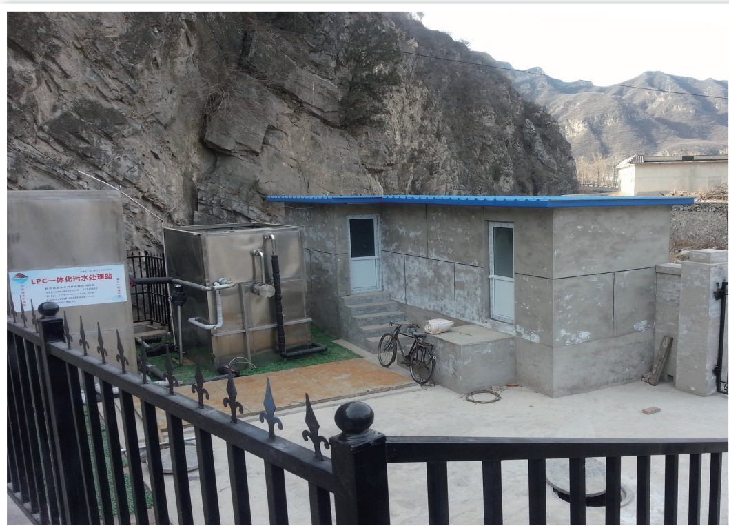
门头沟樱桃沟小流域污水处理
