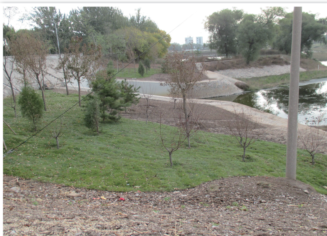
通州区港沟河(上段)小流域河滨带治理
