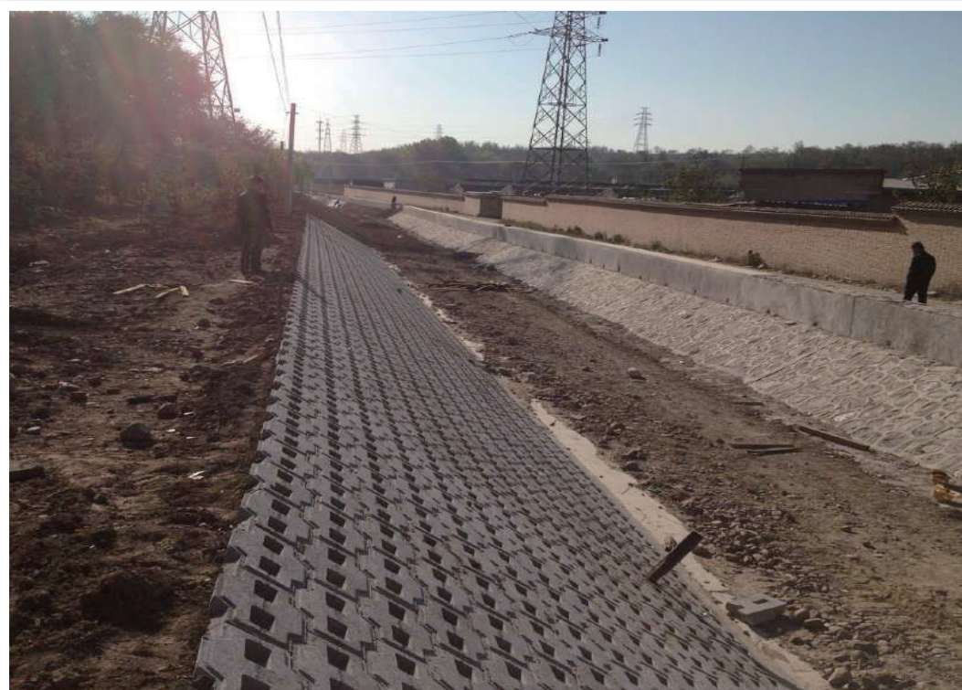
丰台区李家峪小流域沟道整治
