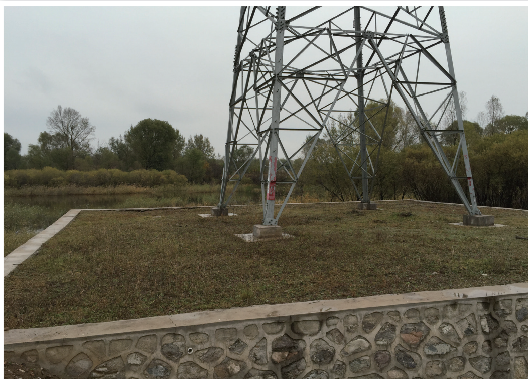
张山营110KV输变电工程水土保持措施
