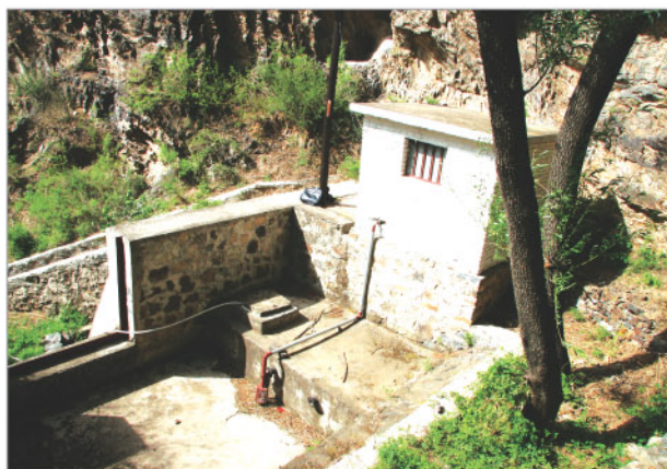
房山区下道峪沟道控制站
