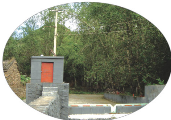
门头沟区田寺沟道控制站
