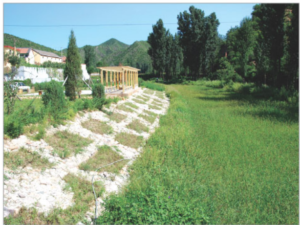
怀柔区庄户沟小流域岸坡防护
