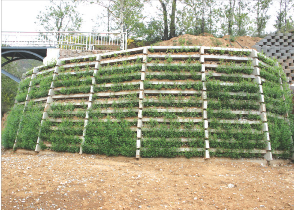
上辛庄开发建设项目试验示范基地陡坡防护—植被混凝土格栅挡墙
