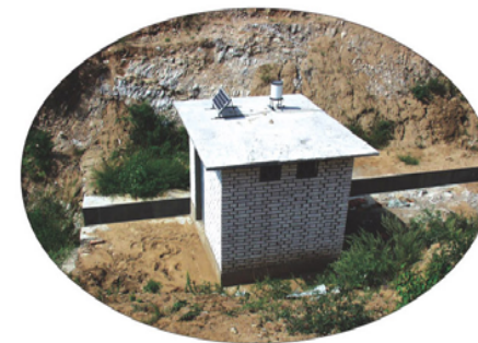
延庆上辛庄北沟沟道控制站
