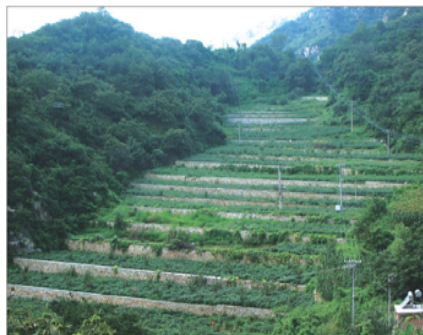
生态治理—怀柔椴树岭小流域石片沟梯田
