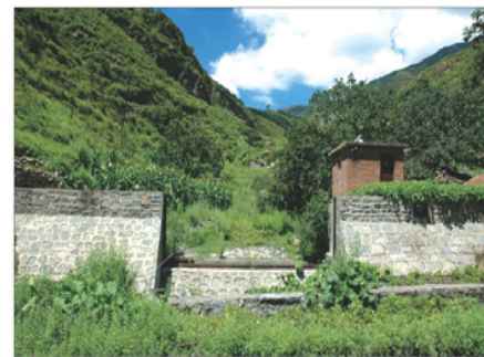
房山西泥洼沟道控制站
