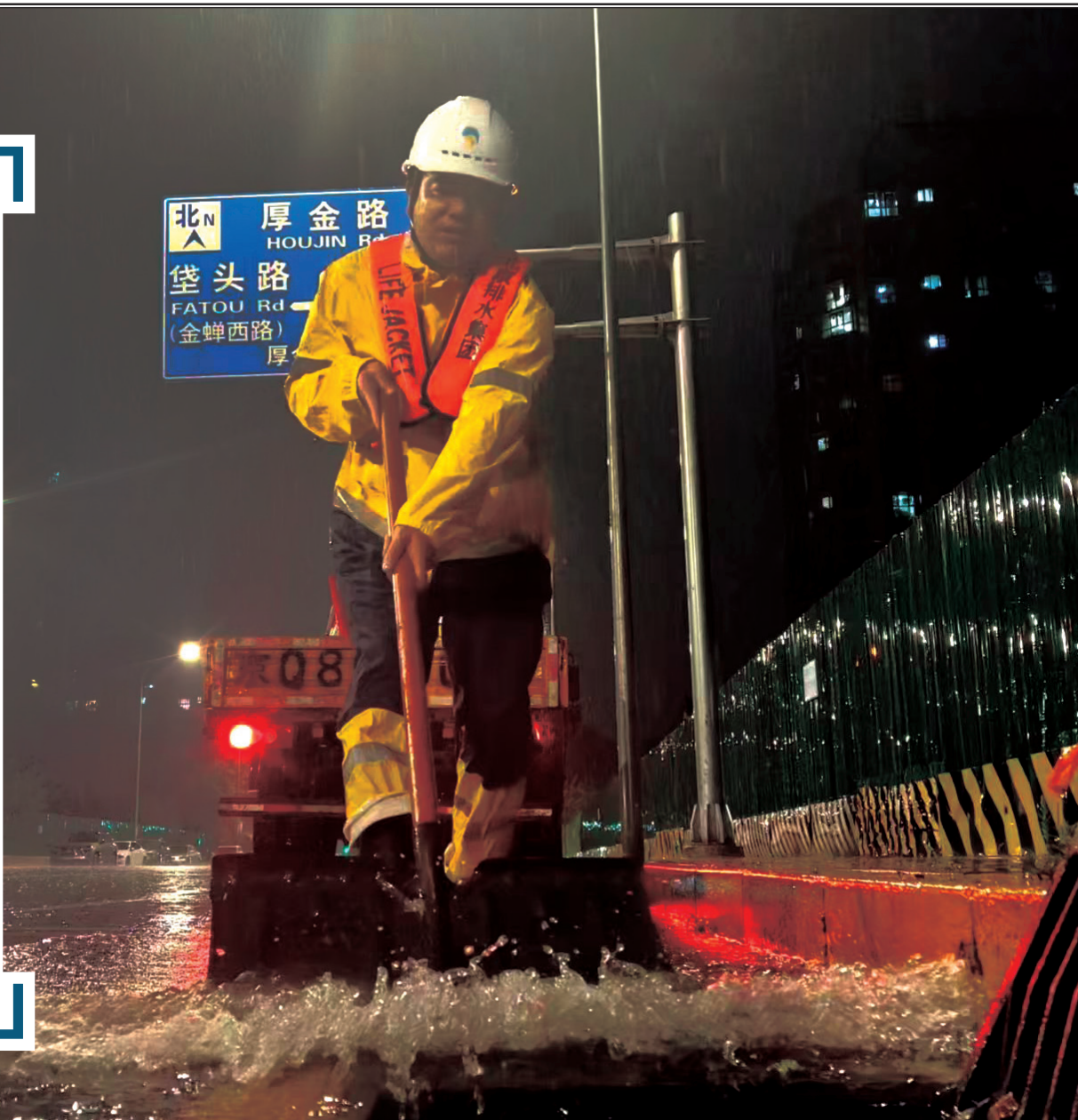
北排第二管网分公司进行推水作业
