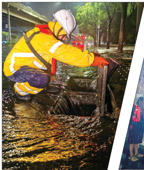
北排第三管网分公司清理雨水口
