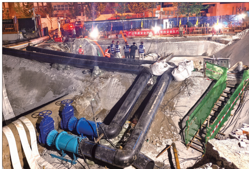
东水西调管线改移施工现场
