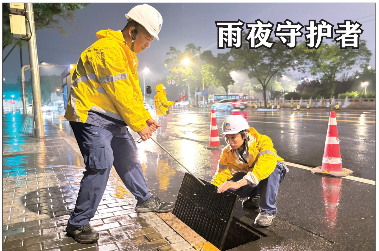
5月16日16时，本市发布暴雨蓝色预警。为应对该轮降雨，市区水务部门加强与气象部门会商研判，动态跟踪降雨落区变化，及时做好降雨防范应对工作。图为北京排水集团第三管网分公司运行三班工作人员在清华西路圆明园南门巡查。 摄/高晓路
