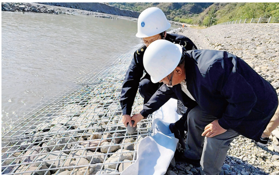
水务与城管就水利工程安全质量联合现场勘查
