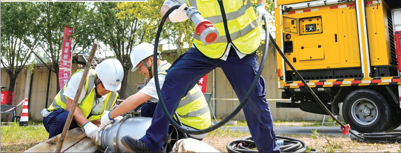
北京排水集团开展2025年防汛抢险大比武
