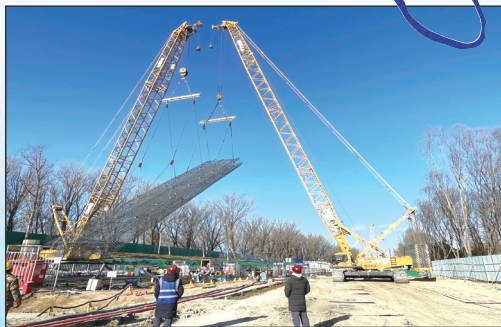
防冲墙钢筋笼吊装
