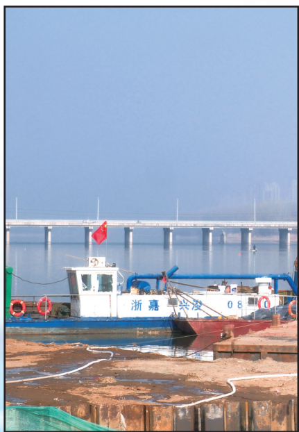
绞吸船正在进行河底平整施工 摄/李森
