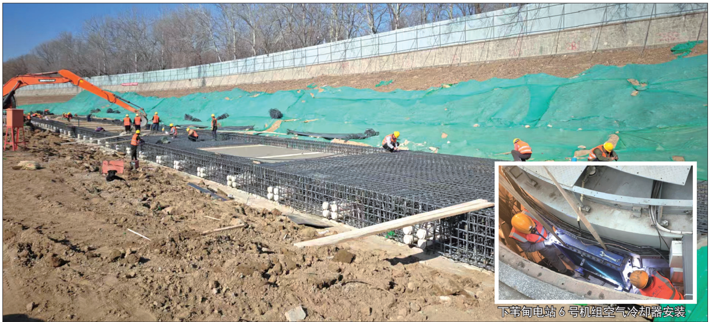
永定河卢梁段项目冠梁拉结板钢筋安装
