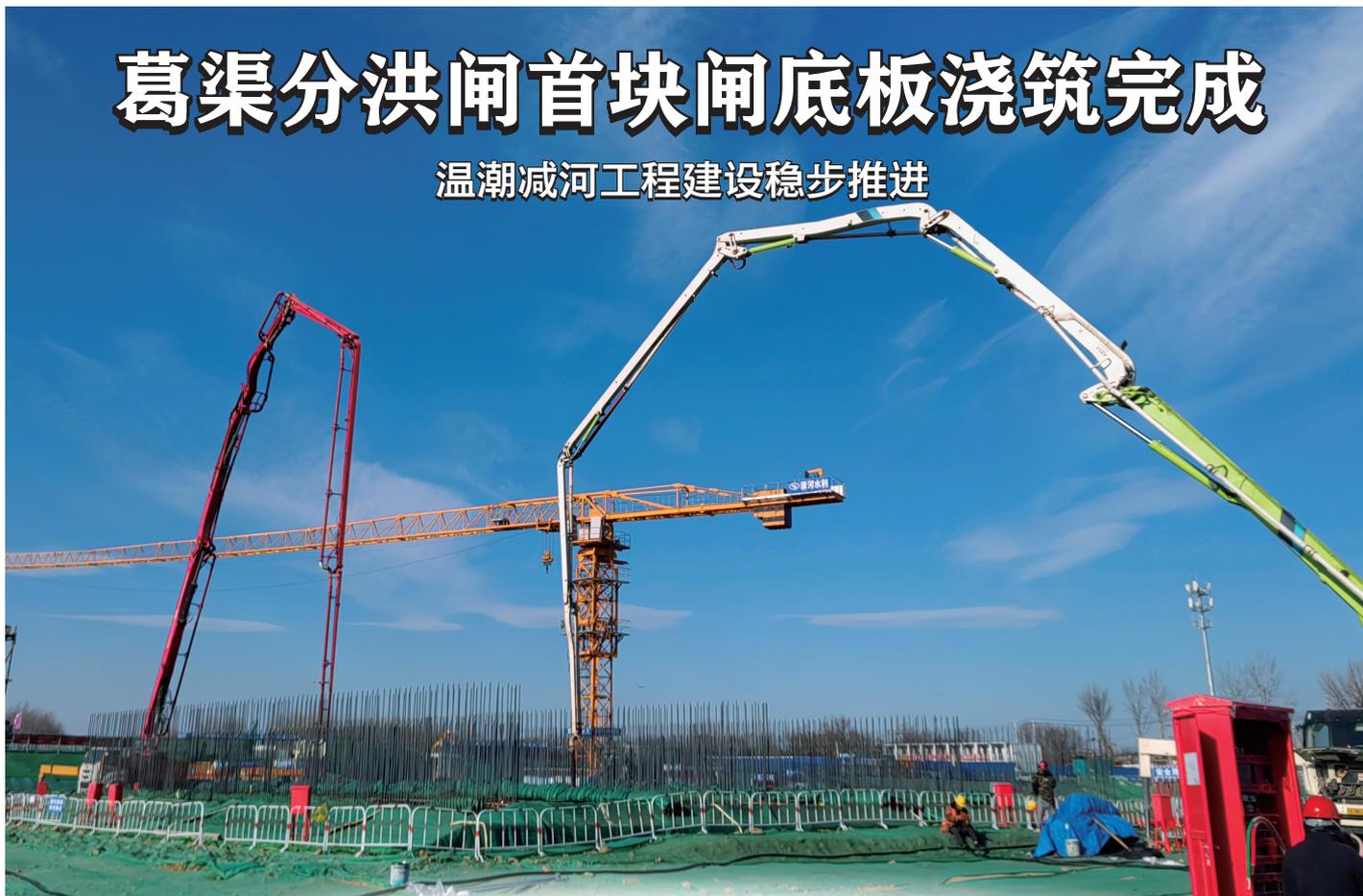
本报讯(通讯员 陈蕊 郑艳侠)近日,随着最后一台天泵缓缓收起“臂架”,历经20小时不间断作业,温潮减河工程葛渠分洪闸首块闸底板浇筑完成,标志着葛渠分洪闸工程从基础准备转入主体施工,为后续工程搭建框架奠定整体质量与进度基础。
