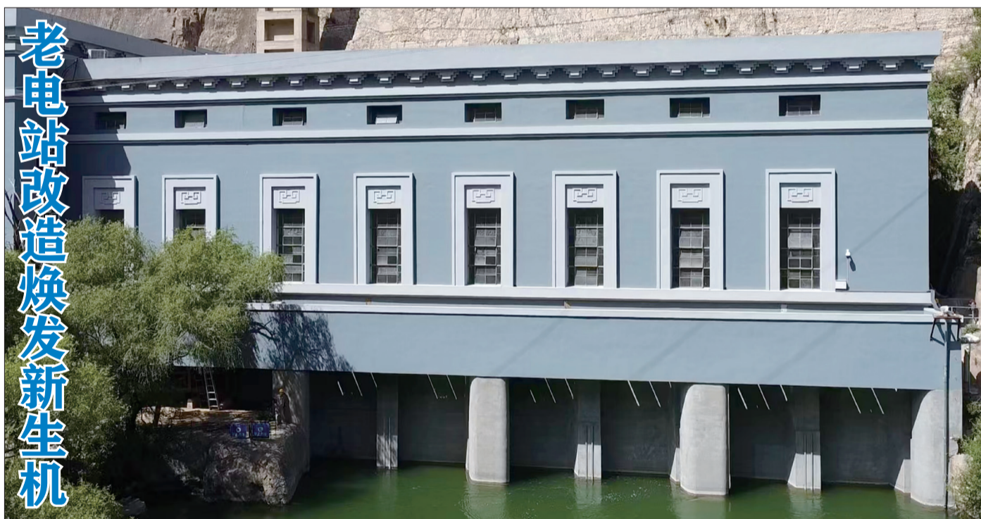
日前，官厅水电站3台机组改造工作全部完成，成功进行并网测试。作为新中国成立后华北地区兴建的第一座水电站，改造后的官厅水电站调蓄和发电效能进一步被激发。 文/通讯员 肖芬
