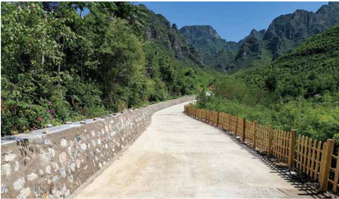
房山区平峪小流域田间生产路
