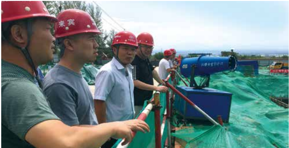
检查冬奥会配套水务项目
