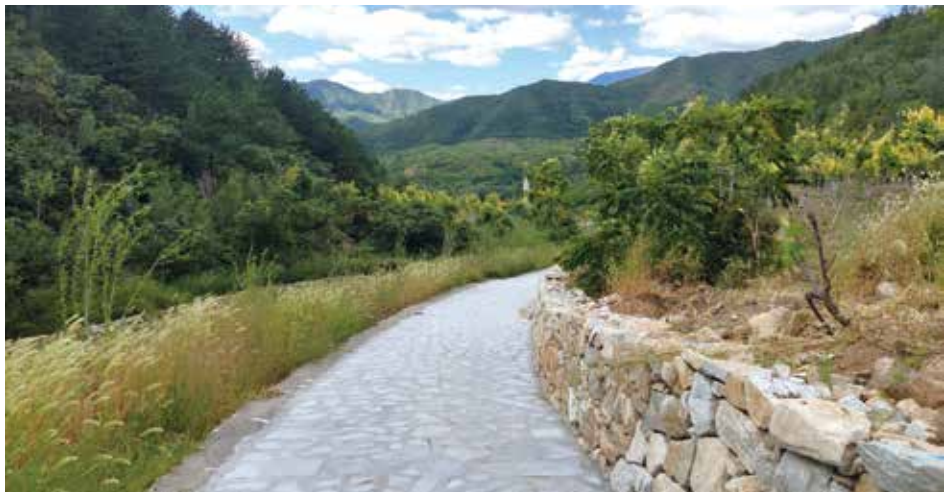
怀柔区道德坑小流域步道
