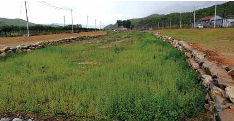
怀柔区东南沟小流域驳石护岸
