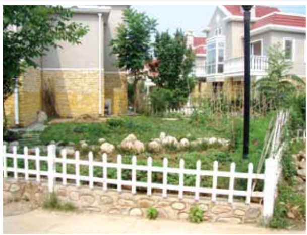
平谷区房地产世外桃源二期项目水土保持措施
