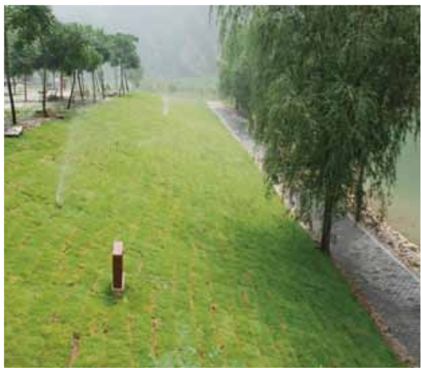
延庆县六道河小流域生态护坡
