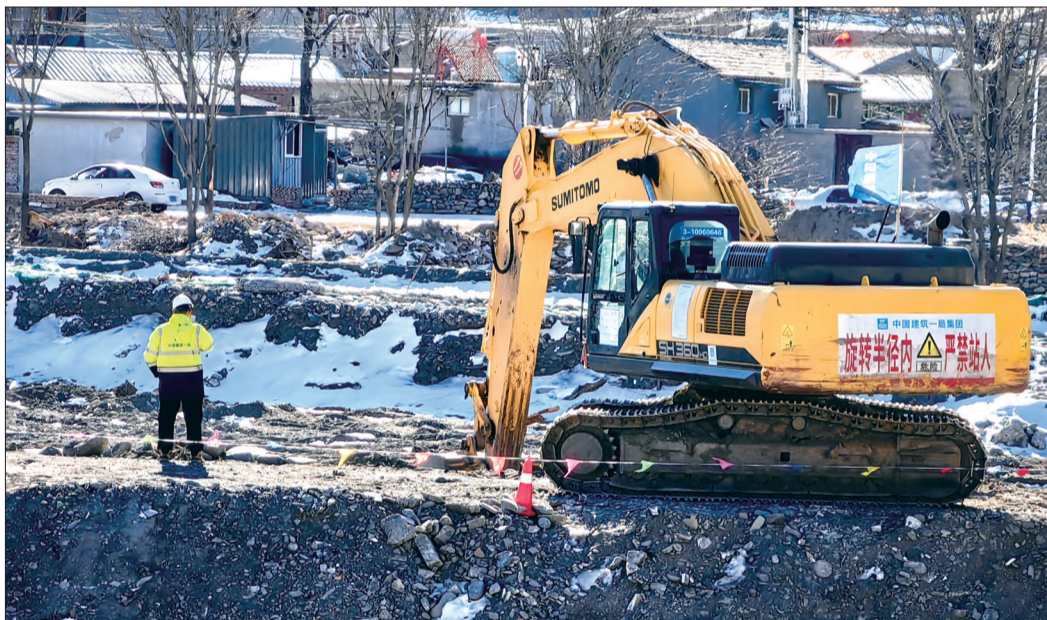
大石河水毁修复工程施工现场
