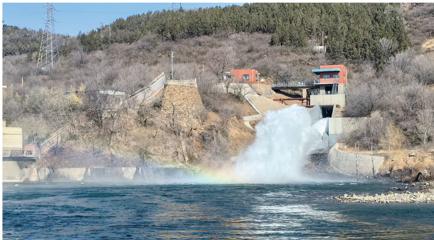
日前，本市陆续启动永定河北京段、潮白河、北运河生态补水工作。市水务系统各部门各单位周密部署、统筹协调、通力配合，全力保障年度生态补水目标顺利实现。图为潮河输水隧洞出口。
